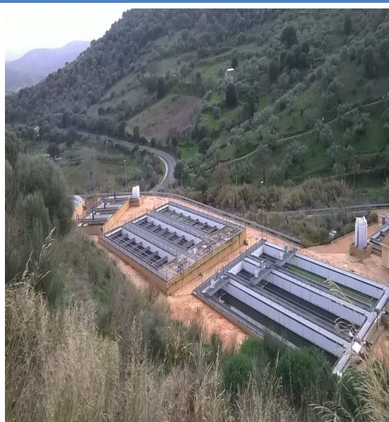
Panoramica struttura depurativa
