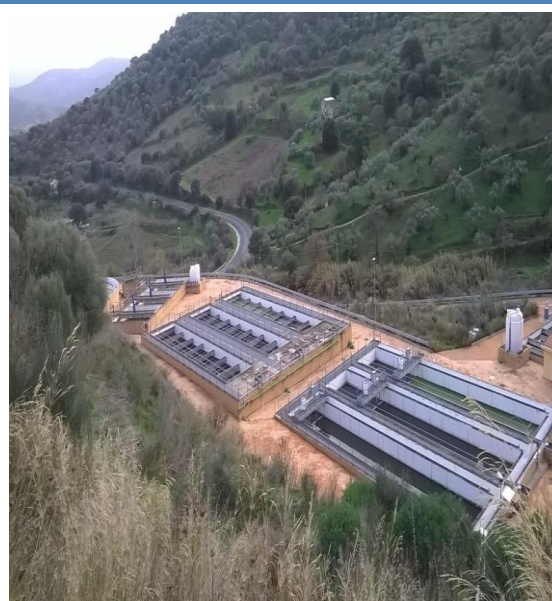
Panoramica struttura depurativa
